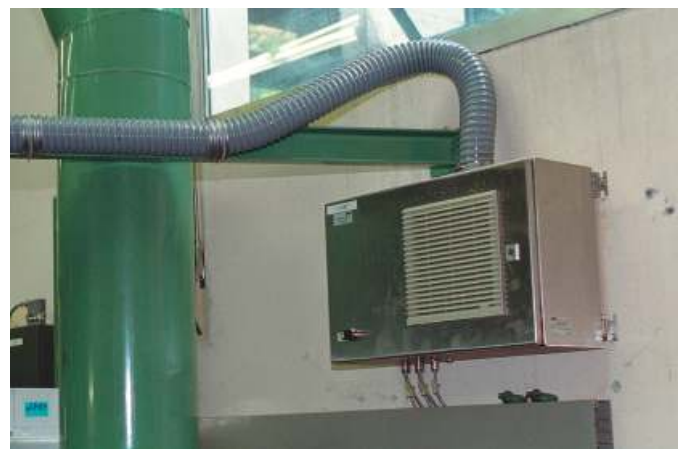
Production d'air soufflé et boîte de connexion pour les appareils VLM 200 SD
